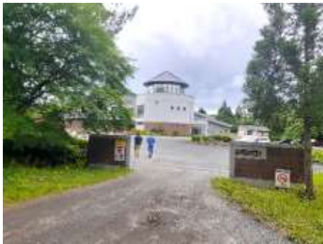
伊手小学校現地調査
